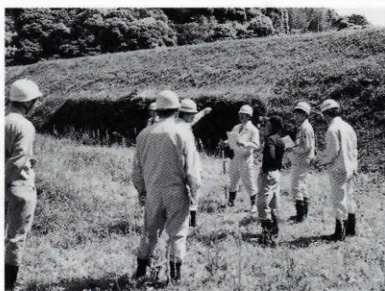
▲県と町で毎年実施する危険ため池パトロール
