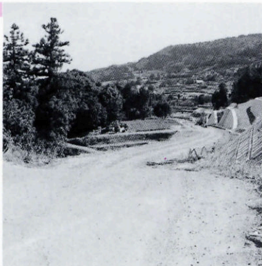
工事中の町道蔵小田・宇津賀線
