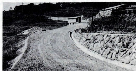
完成した西ノ谷農道
