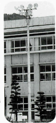
▲積立金還元融資施設 (厚生年金、国民年金) 通中学校夜間照明施設
