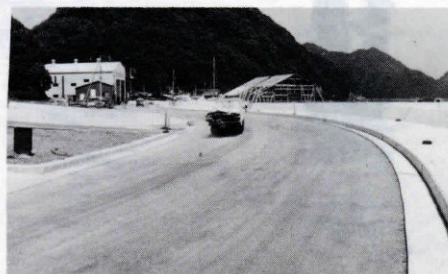
市道真弓の木線と護岸工事
