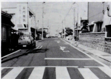
市道の舗装(仙崎新屋敷区)
