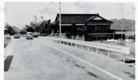
ガードレール設置(河原地区)
