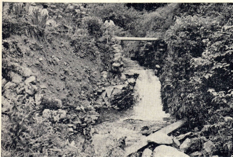
▲ 集中豪雨のため破かいされた河川と田に 土砂が流出(浜木大峠)
