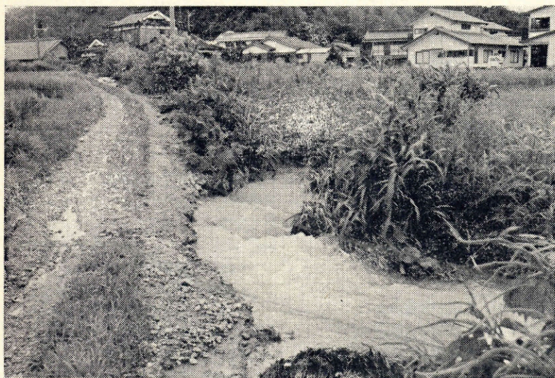
▲ 中山池田線(破かいされた道路と河川)東深川中山
