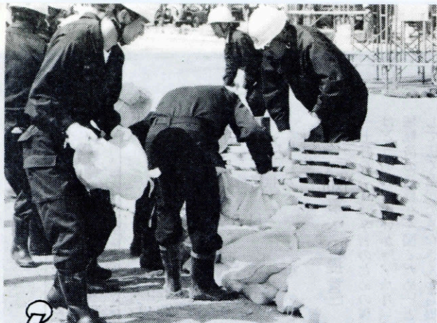
町消防団の水防工法実施（積土法・しがらみ）
