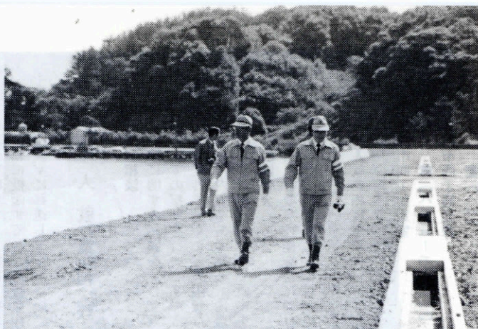
町長ヘリコプターで現地到着後災害現地視察
