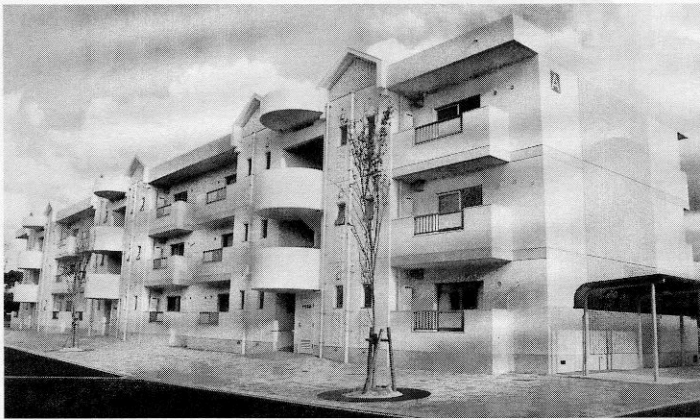
▲ 完成した上城公営住宅
