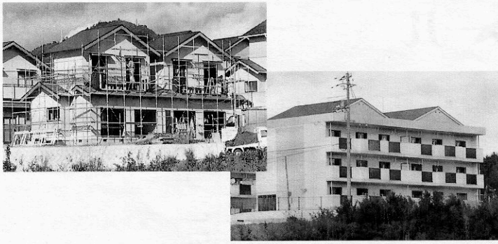
〔建設中の町営住宅〕
