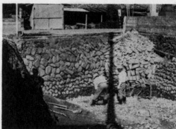
善福寺横の防火水そう改修工事
